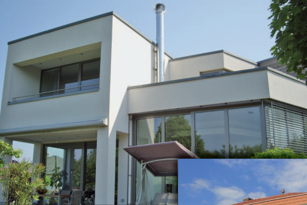
Modern gestaltete Baukörper (oben) tragen ein höheres Risiko als Gebäudekonstruktionen mit großen Dachüberständen im sogenannten Landhausstil. (Fotos: Baumit)
